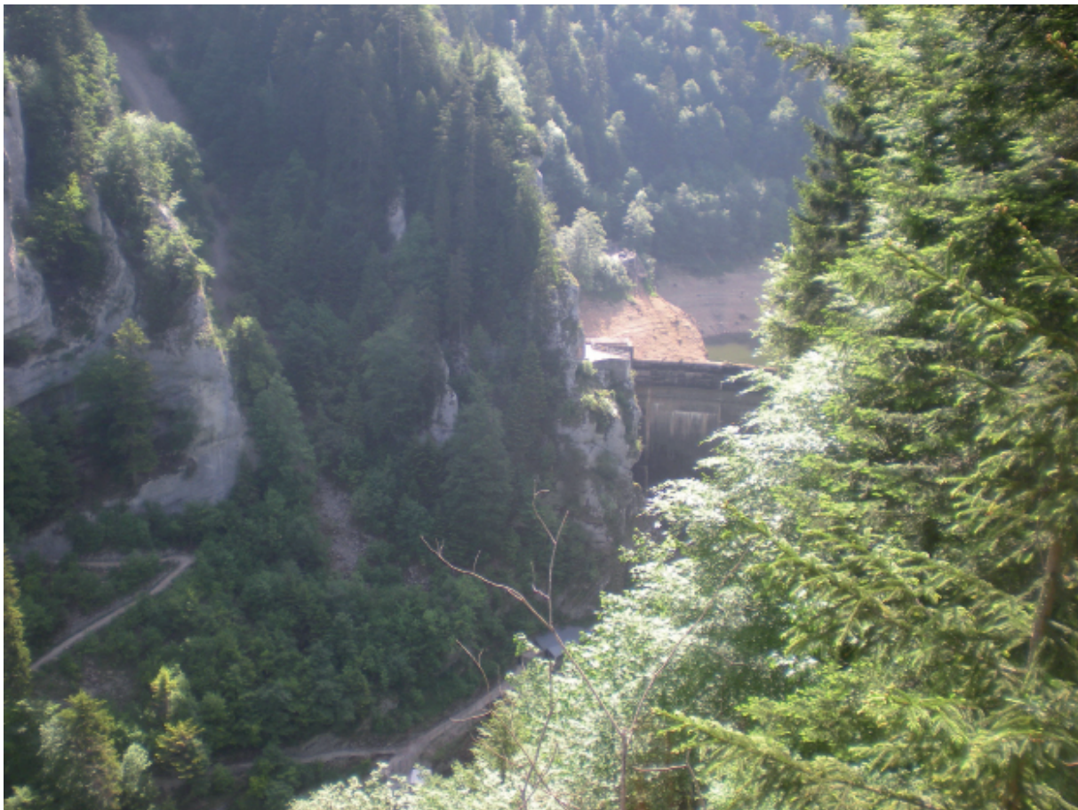
17. links Zwitserland---rechts Frankrijk---- Ertussen : Le Barrage du Chatelot.
